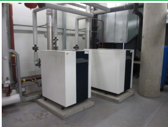
Technische ruimte met c.v.-ketels
